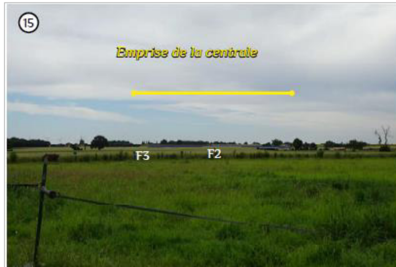
15 Emprise de la centrale Vision depuis le hameau de la Petite Saunière face aux berges F2 et F3. La surface en eau du bassin n'est pas visible. A l'extrémité de la pente F3, sont construits les 2 postes électriques
