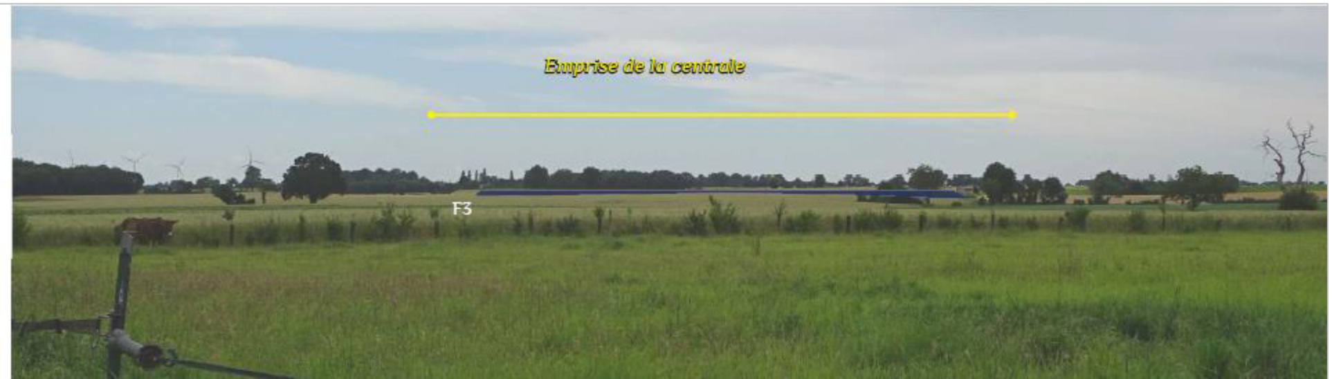
Photo 15 : zoom Sur ce panorama localisé au Sud-Ouest, la vision de la partie flottante de la centrale flottante est nulle. En revanche les tables installées sur la pente F2 du bassin sont visibles franchement, tout comme les postes qui apparaissent à l'extrémité de la face F3 du bassin. Des éoliennes apparaissent dans le panorama. Au vu de l'éloignement, de la richesse des motifs paysagers et de la vision franche à nulle en fonction des composants de la centrale, la prégnance de cette dernière dans le panorama global est considérée comme faible
